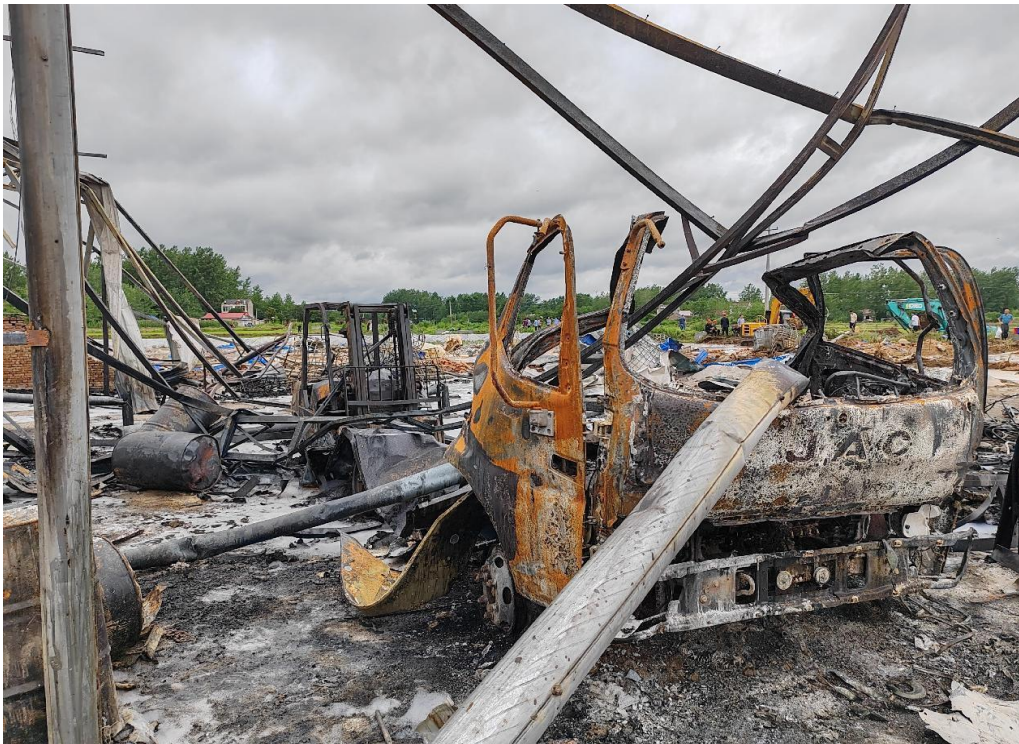
图 3 事故厂房中部区域爆炸后情况（自东向西）
