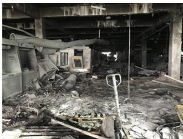
图7 凹陷的地面楼板
