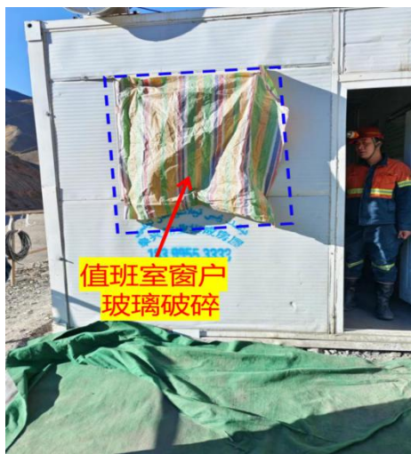
图5 值班室的窗户（外面已破碎） 图6 现场彩钢房发生明显变形图
