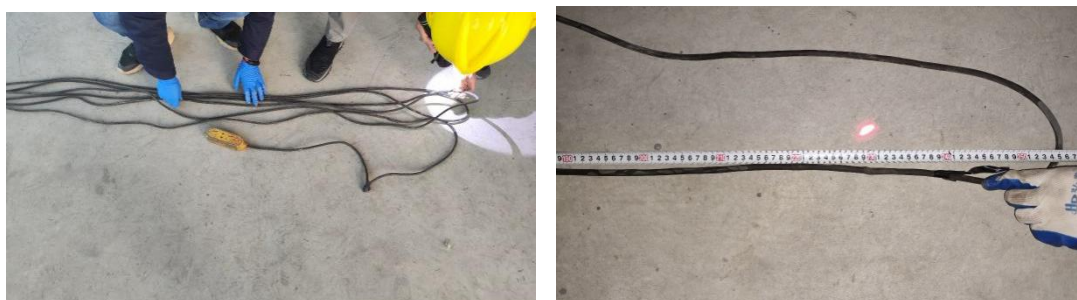
图 10 黄色三插位插座电缆破损处位置
