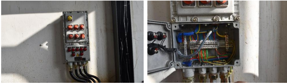
图 8 黄色多功能插座连接的防爆照明（动力）配电箱
