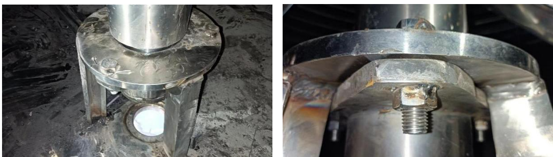
图 7 事故反应釜底部搅拌轴下定位底轴承三角支架
