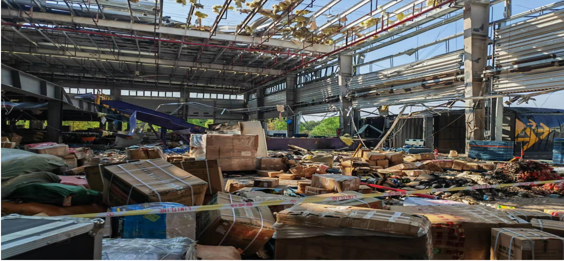
图 1 事故现场情况
