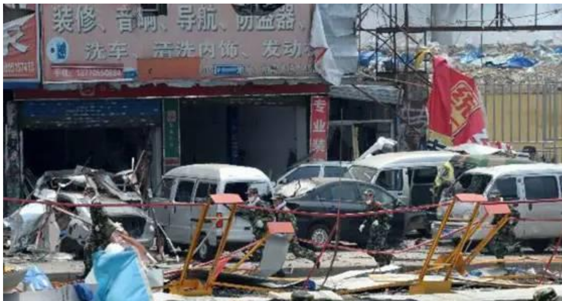
图 2 事故地点周边破坏情况
